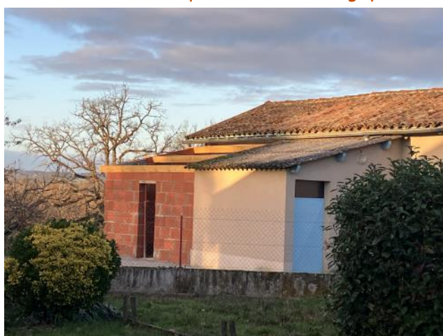
Local de stockage du Bar associatif
